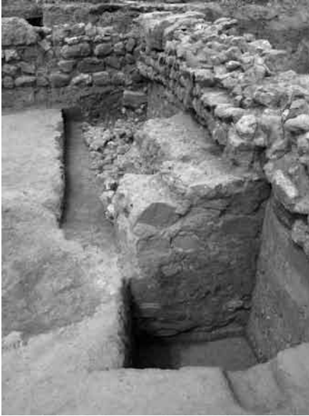
Fig. 15. Pilar y plataforma de unión de los pilares con el muro de fachada.
