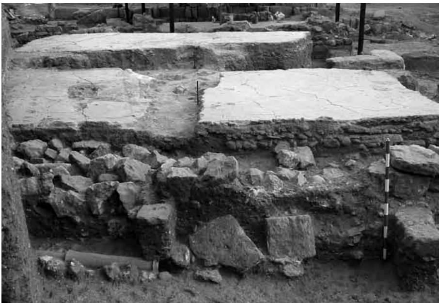
Fig. 14. Edificio de baños desde el Sur. En primer término muro de fachada, canalización de desagüe y pavimentos hidráulicos.
