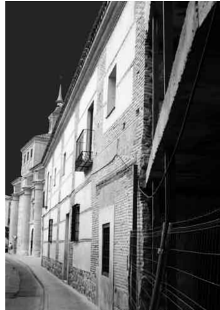
Fig. 10. Alcalá, construction neuve, rue Santa Clara, Juin 2002.
