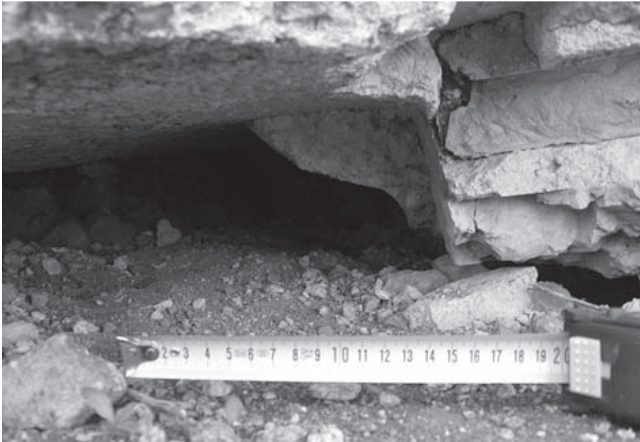
Fig. 14. Detalle de la media caña realizada en opus signinum y del mismo material queda revestido toda la estructura en la parte externa de la construcción o interna del derrumbe.
