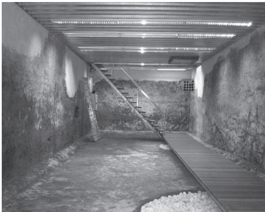
Fig. 2: Acceso a la cisterna romana de la Plaza de la Pescadería. En el proyecto arquitectónico se ha optado por colocar una escalera para acceder al interior de la cisterna de forma que la afección al edificio sea la menor posible.
