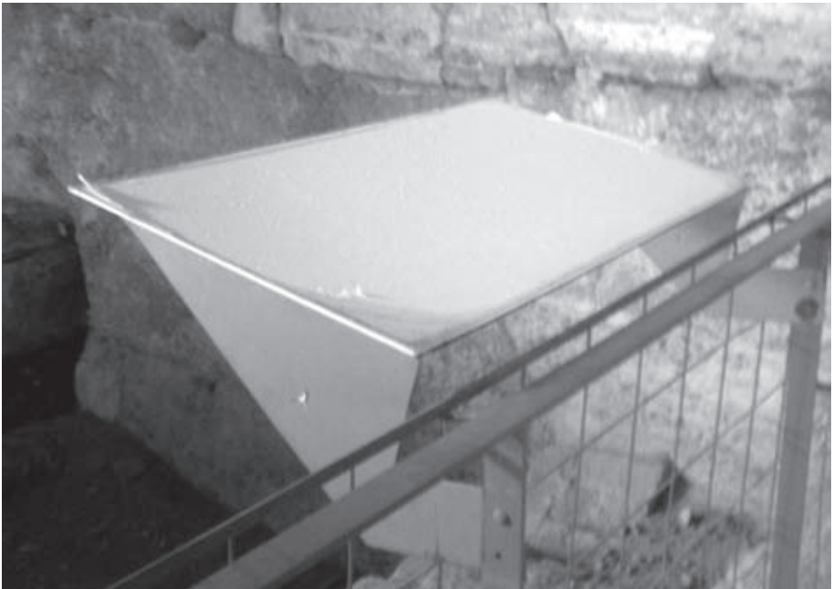
Fig. 10: Estado actual de la panelería informativa en las Atarazanas. El deterioro de los paneles informativos es claramente visible.
