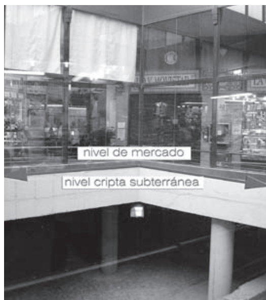
Fig. 11. Detalle de cripta subterránea con vista del nivel de mercado.
