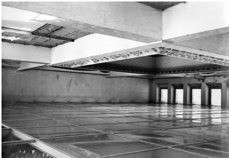
Figura 39. Detalle de la estructura de las salas de exposición temporal insertas dentro del pabellón de Bellas Artes, del que se puede apreciar restos de la cubierta de los casetones de escayola.
