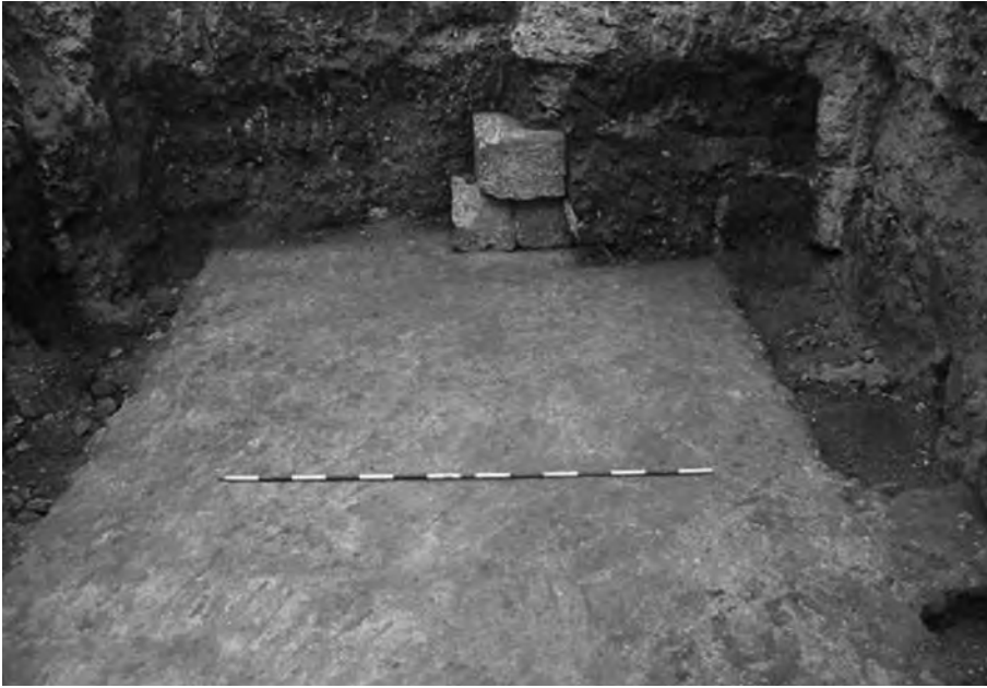
Fig. 27: Tramo correspondiente a la U.E. 163 (N-S), de la cimentación en forma de "L" invertida.
