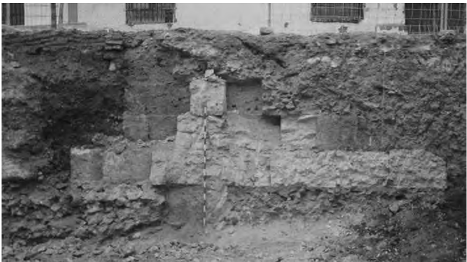
Fig. 20: Construcción aparecida en el solar de Galindo nº 2, en el perfil a Emilio Castelar.
