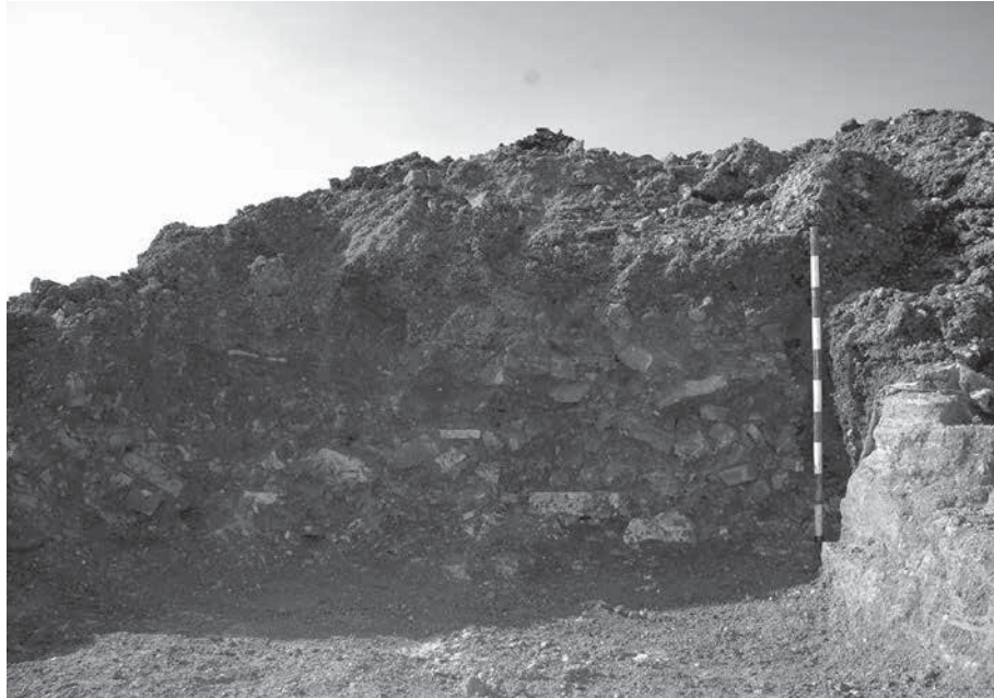
Figura 13. Vista de los rellenos que sepultan la mitad sur de la galería occidental, en los que se documentan los derrumbes de muros.
