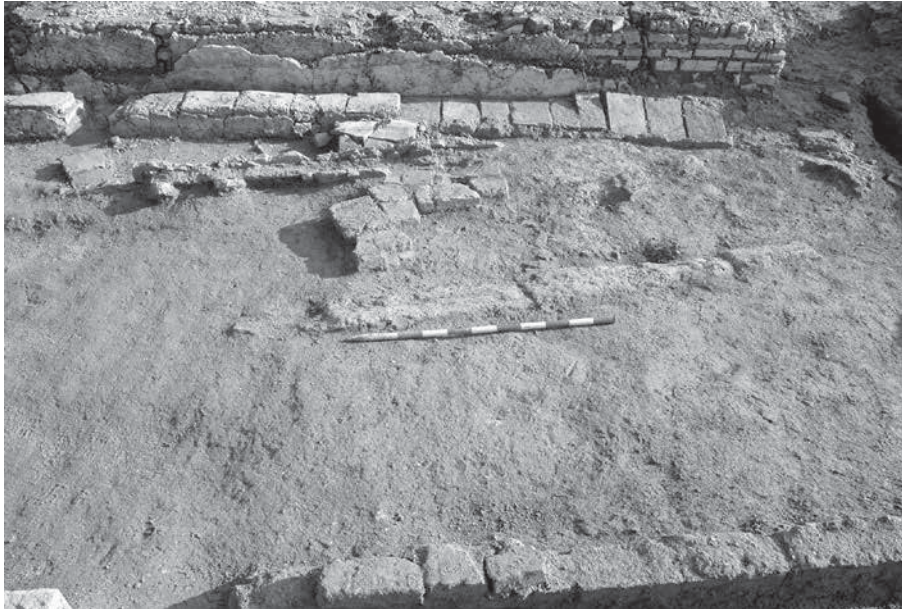
Figura 11. Detalle de las cornisas caídas.
