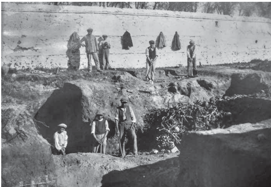
Figura 4. Imágenes de las obras de construcción de las fosas de hormigón en 1928 y documentación de provisión de fondos. Se puede observar los desmontes verticales que, posteriormente y según nuestra hipótesis, se emplearían como encofrado en las primeras fases de la obra. Fuente: Archivo Municipal de Lucena.
