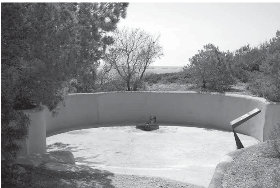
Figura 6. Plataforma de tiro de la batería de costa de la Ametlla de Mar (Tarragona) (Autor: Jordi Ramos).
