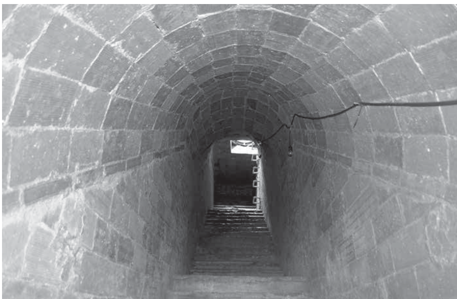
Figura 12. Galería en mina del refugio antiaéreo ubicado en la Plaza de Las Navas del barrio del Poblesec de la ciudad de Barcelona (Autor: Jordi Ramos, ATICS SL).
