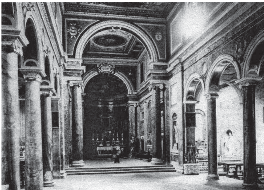
Figura 10. Tivoli, chiesa di S. Pietro alla Carità, aspetto interno della chiesa prima del bombardamento (da Bernini 1987)
