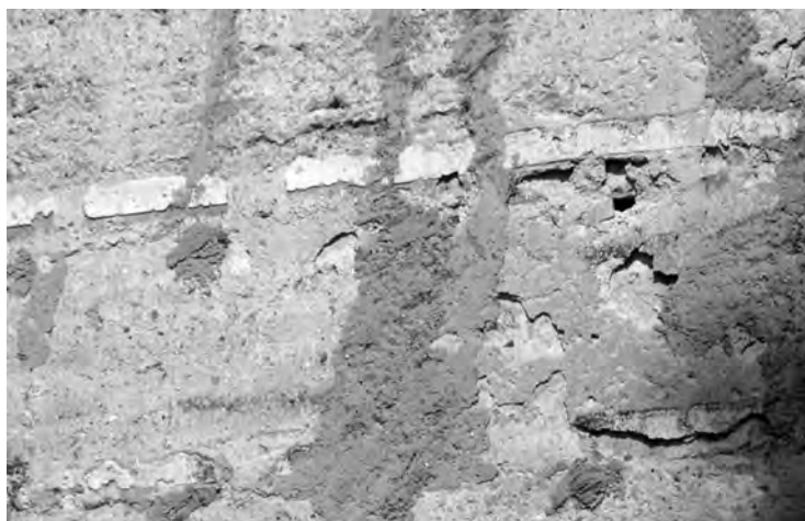
Fig. 6. Falso despiece de encintados de mortero de cal en la Torre Blanca de Sevilla (fotografía de Daniel Jiménez).
