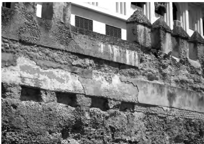
Fig. 5. Superposición de las dos fases de la muralla del lienzo del Agua y el conducto de los Caños intercalado (fotografía de Daniel Jiménez).
