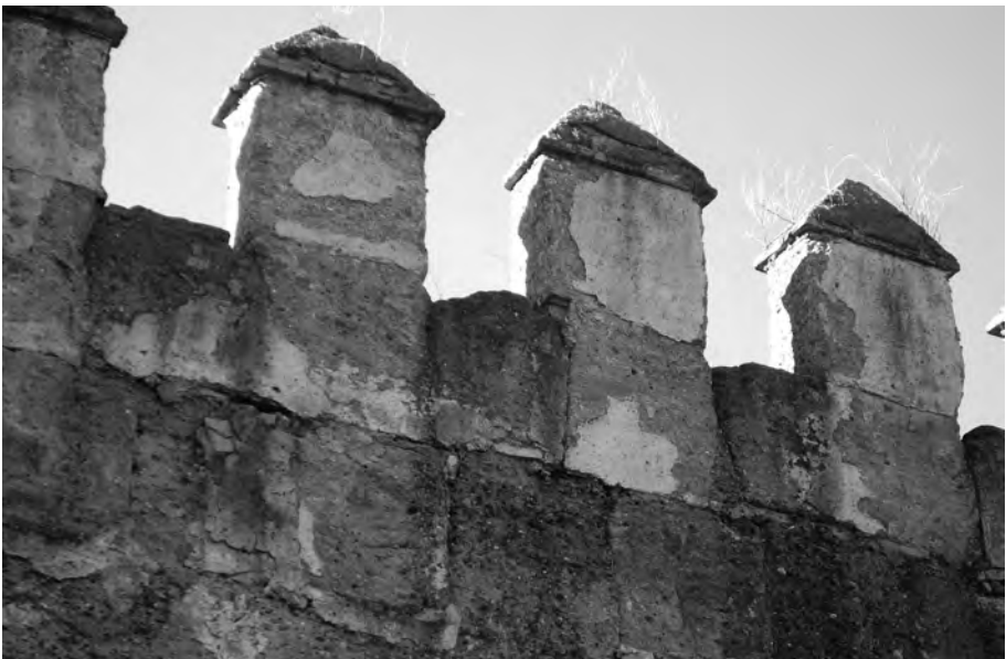
Fig. 3. Superposición de las dos fases de la muralla en la Macarena. Sector Puerta de Córdoba (fotografía de Daniel Jiménez).
