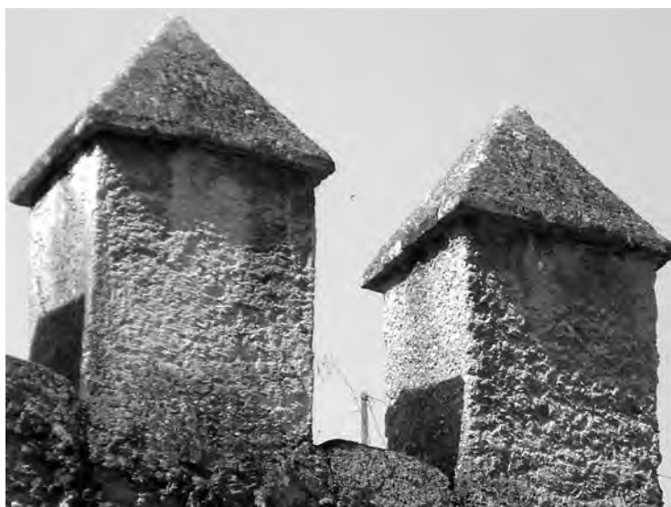
Fig. 7. Merlones con albardillas piramidales y rebajas curvos en el parapeto entre ambos en un lienzo de las murallas de la Macarena (fotografía de Daniel Jiménez).
