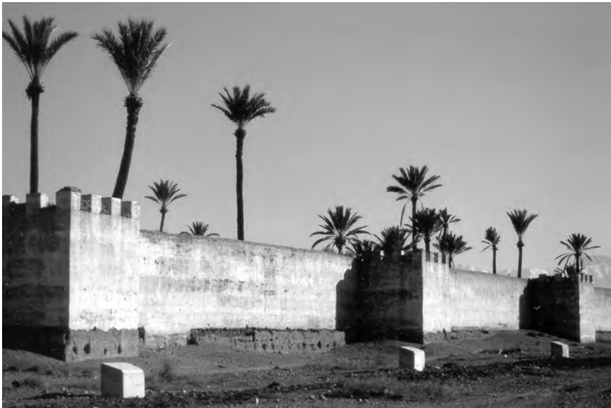
Fig. 10. Vista de las murallas almorávides de Marrakech (fotografía de Daniel Jiménez).
