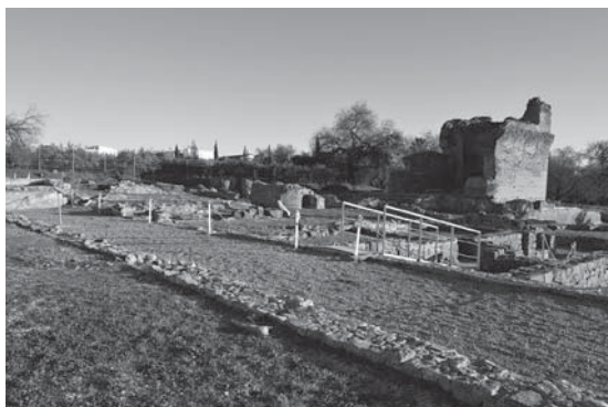
Figura 22. Circuito de visita y pasarelas para cambios de nivel. Foto de la autora.
