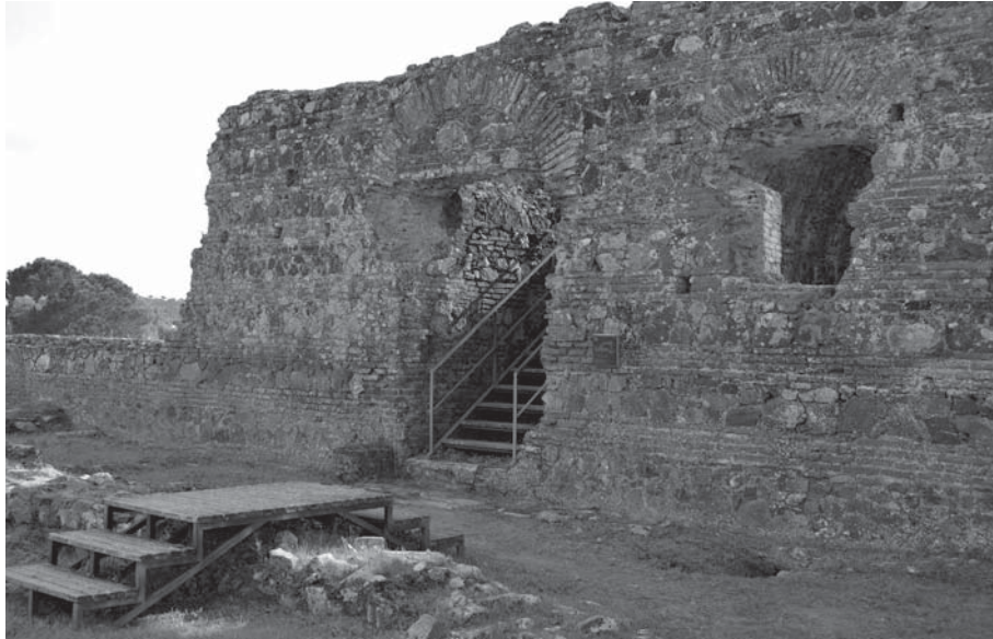
Figura 15. Estructura para salvar desnivel y escalera de acceso a cubierta. Foto de la autora.
