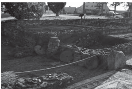
Figura 26. Estado de conservación de estructuras. Foto de la autora.
