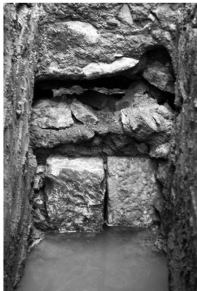
**Fig. 14.** Sanxay, temple octogonal cruciforme. Fondations de la cella dans la nappe phréatique (photo auteur).
