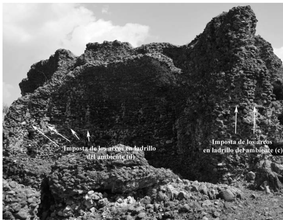
Fig. 13. Termas de las Bóvedas, Ambientes (c) y (d), detalle de los arranques de los nervios de ladrillo (A. Ottati).
