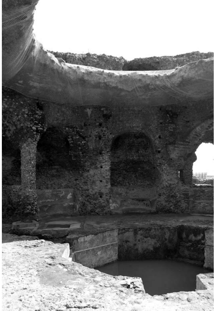
Fig. 6. Termas de Las Bóvedas, interior del ambiente central, foto desde el sur: detalle de las hornacinas y de la bóveda anular (foto A. Ottati).
