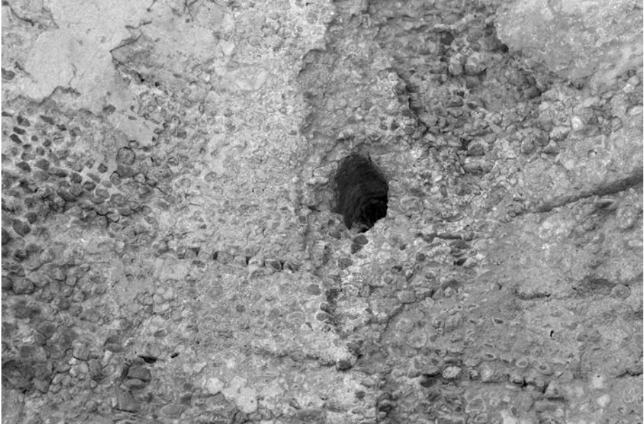
Fig. 12. Termas de Las Bóvedas, detalle de las bóvedas (foto A. Ottafí).
