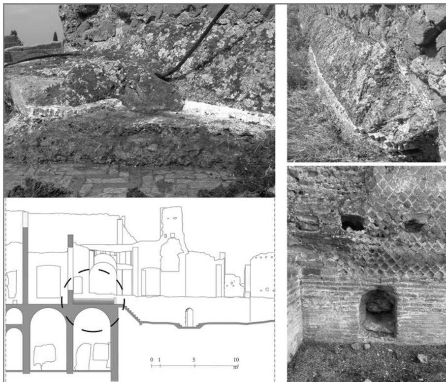
**Fig. 22.** Evidenza della vasca realizzata, nel corso di un ripensamento in fase di costruzione, sull'estradosso della volta di copertura dell'ambiente a sud.
