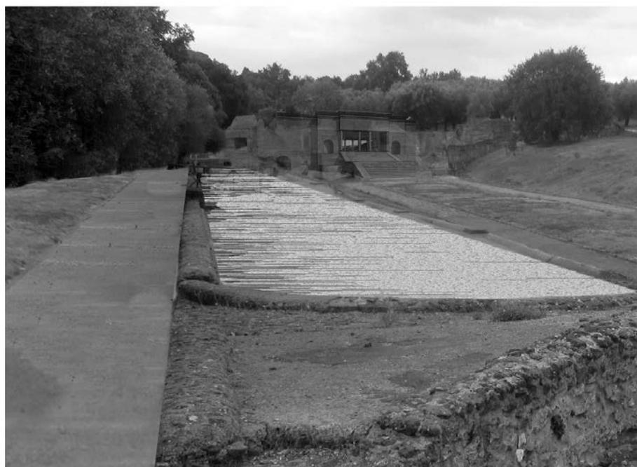
**Fig. 31.** Simulazione grafica dell'esistenza di una bassa vasca disposta sull'estradosso del braccio meridionale delle Cento Camerelle (autore).
