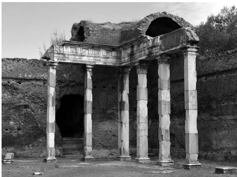
Fig. 17. Villa Adriana, cd. Sala dei Pilastri Dorici, porzione del portico oggetto di anastilosi (autore).
