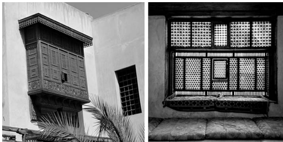
Fig. 2. Esempi di claustrum : a sinistra: Dubai, Emirati Arabi, a destra: Oman (da TROMBETTA, 2002,203).
