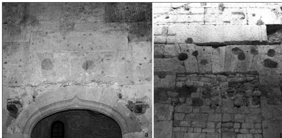
Fig. 4. Aperture finestrate documentate nel lato occidentale (a) e orientale (b) della terrazza superiore del Foro Provinciale (foto autore).
