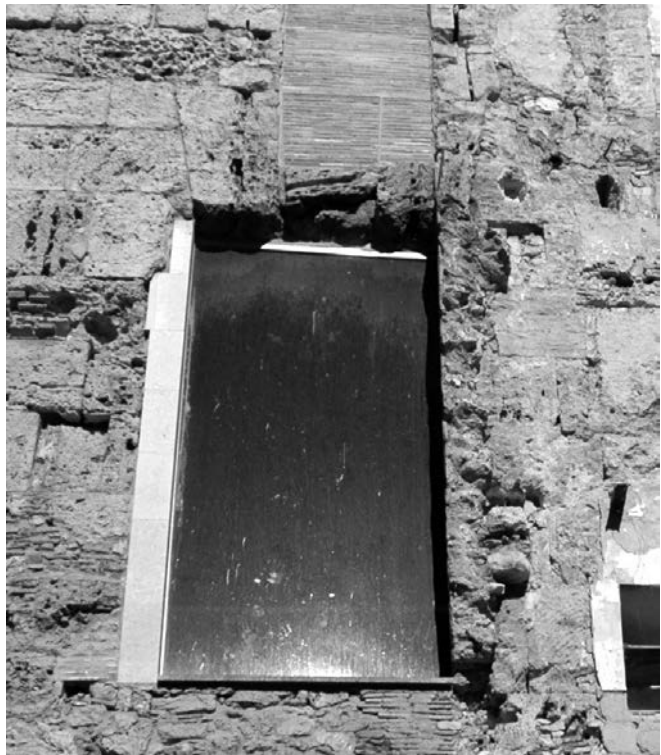
Fig. 6. Apertura finestrata del muro meridionale della Torre de la Antiga Audiència (foto autore).
