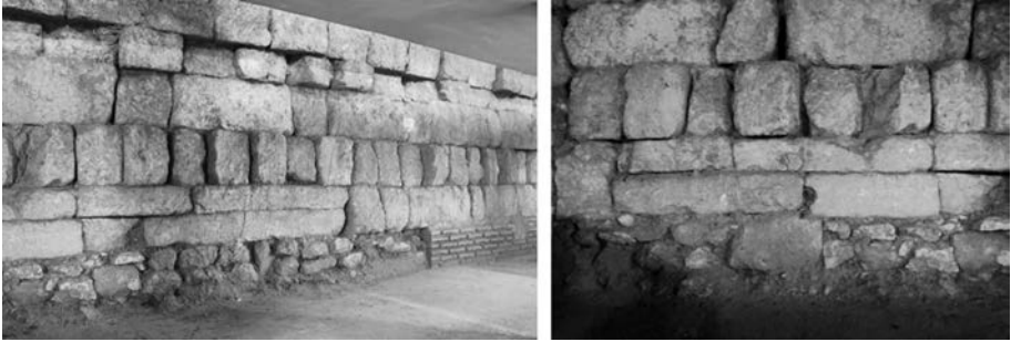
Fig. 8. Fondation de la courtine principale à Ronda de los Tejares ° 13 face intramuros «à gauche» (a) et extramuros «à droite» (b) (COURAULT ET AL., 2021, 301, fig. 18-19).
