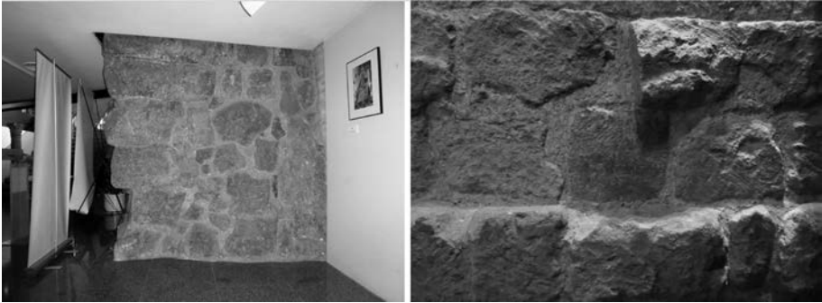
Fig. 13. Trames d'enceintes conservées dans l'entité CajaSur. (a)- Coupe transversale (à gauche), (b)- vue intramuros (à droite) (COURAULT 2016, 132, fig. 44a et b).
