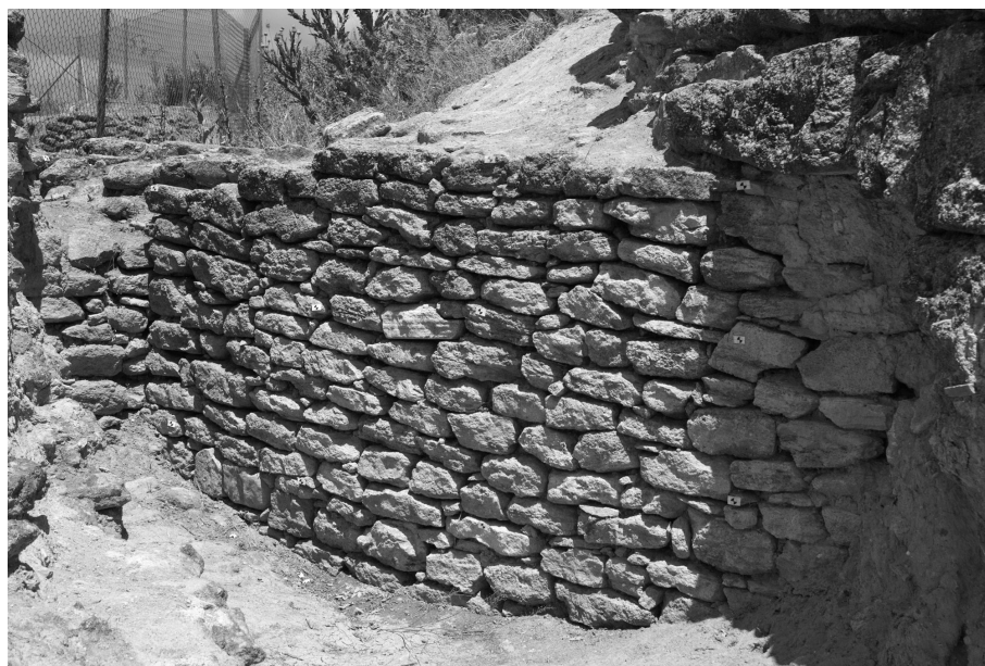
Figura 13. Edificio singular 6. Paramento SE-NW. A la izquierda de la fotografía se puede observar cómo se adosa al muro NE-SW. Ambas estructuras están amortizadas por la fortaleza tardoislámica y en el caso concreto del muro SE-NW por su puerta Sur. ©M º del Camino Fuertes Santos.
