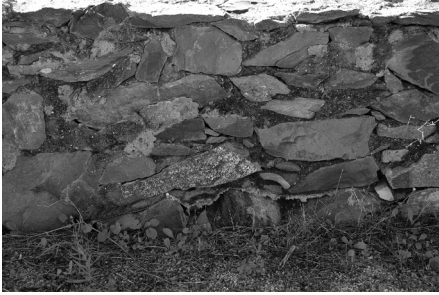
Figura 18. Detalle de conservación de muro. Foto de la autora.
