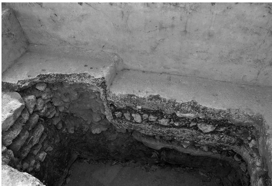
Figura 15. Pozo moderno seccionando los dos niveles del fondo de la piscina 2 y la posible losa de cierre del spiramen L-4.
