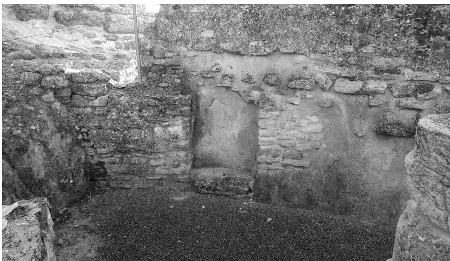
Figura 15. Edificio singular 6. Detalle de la puerta y del paramento NE-SW en el que se abre. ©M º del Camino Fuertes Santos.
