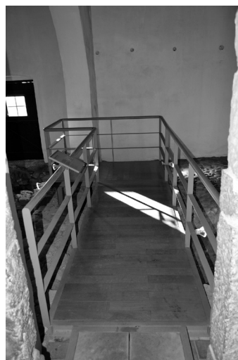
Figura 23. Pasarela en el interior de la casa Rural. Foto de la autora.
