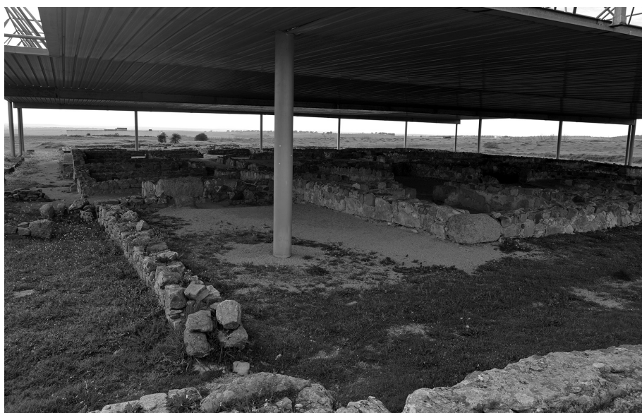
Figura 7. Estado de conservación de las estructuras. Foto de la autora.
