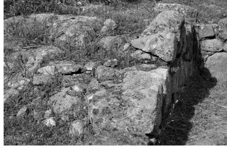
Figura 13. Detalle de estado de conservación de muro. Foto de la autora.
